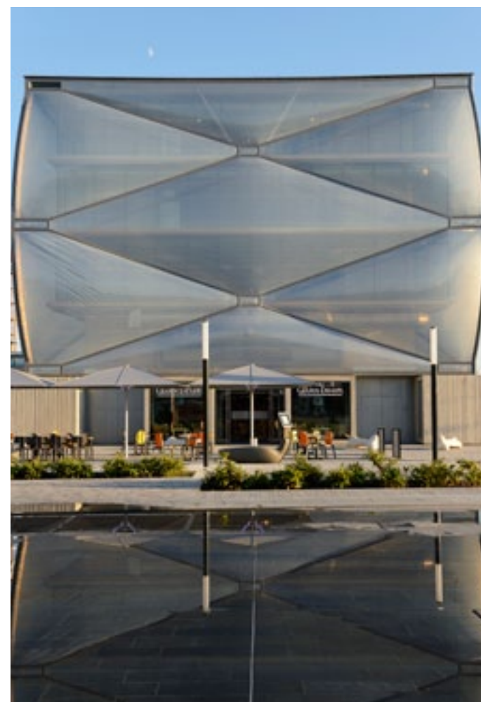
Vue du bâtiment et de son rez-de-chaussée
